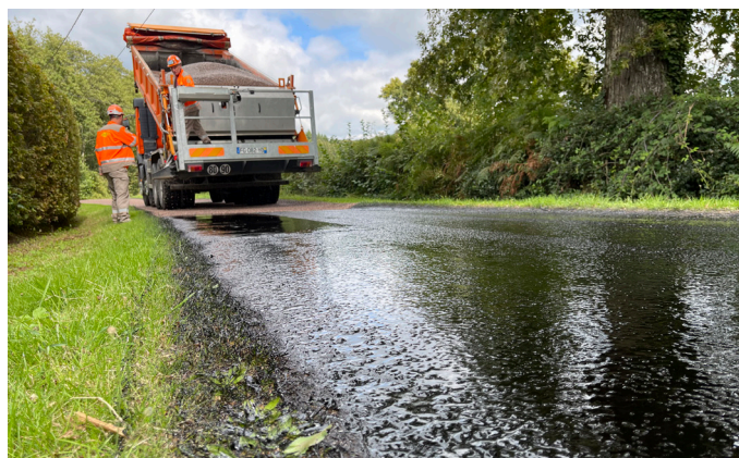
La commune de Saint-Julien-de-Civry a bénéficié de la pose d'un nouvel enduit sur plusieurs sections de voirie par Le Grand Charolais en 2024.
