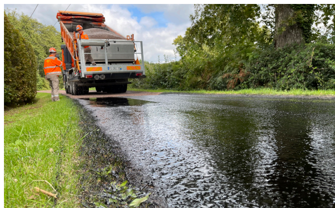
La commune de Palinges a bénéficié de la pose d'un nouvel enduit sur plusieurs sections de voirie par Le Grand Charolais en 2024.
