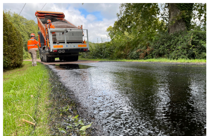
La commune de Mornay a bénéficié de la pose d'un nouvel enduit sur deux sections de voirie par Le Grand Charolais en 2024.
