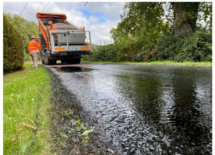
La commune de Lugny-lès-Charolles a bénéficié de la pose d'un nouvel enduit sur plusieurs sections de voirie par Le Grand Charolais en 2024.
