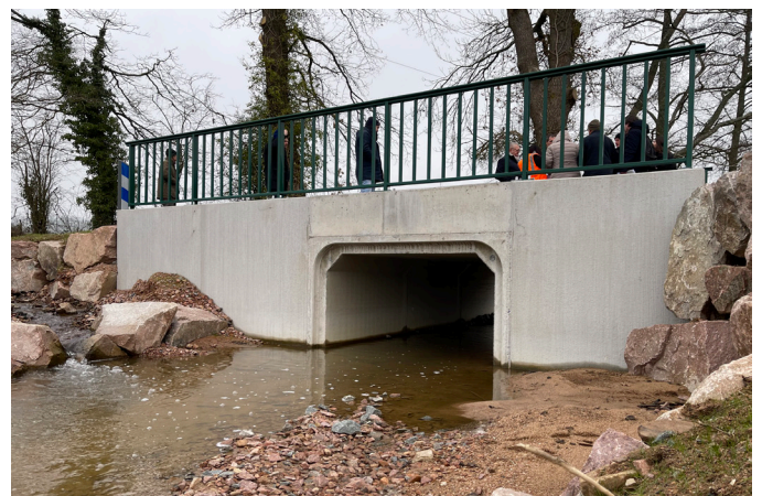
Le pont du Creux Terrier, au Rousset-Marizy, a été intégralement réhabilité en 2024 pour un montant de 90 000 € HT.
