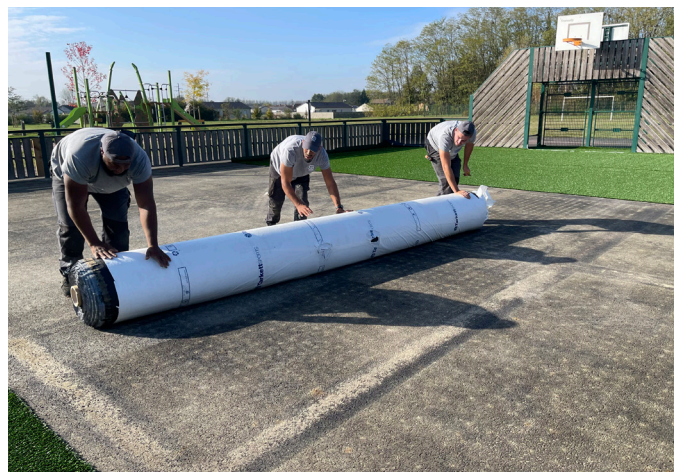
Le gazon synthétique du terrain multisports situé rue des Capucines à Digoin (Neuzy) a été remplacé en 2024.
