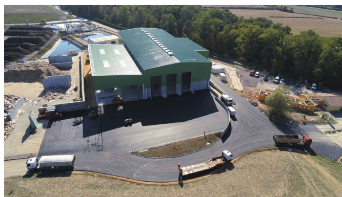
Le bâtiment de rupture de charge à l'entrée du centre de Granges
