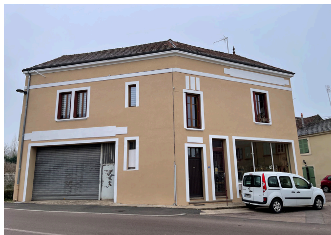
Plusieurs rénovations de façades à Charolles ont bénéficié des aides du Grand Charolais, dans le cadre de l'Opération programmée pour l'amélioration de l'habitat (OPAH).
