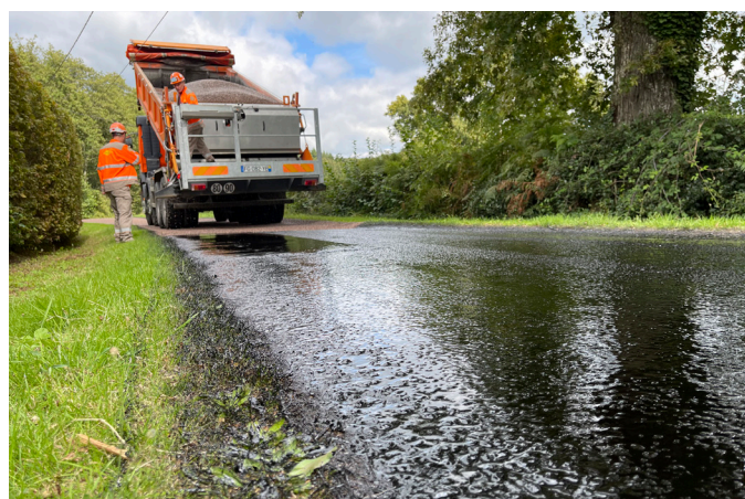
La commune de Ballore a bénéficié en 2024 de la pose d'un nouvel enduit sur deux sections de voirie, financé par Le Grand Charolais.
