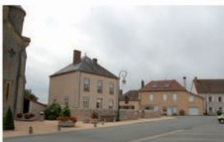
Rénovation de façade avec des couleurs plus sobres, nous pouvons regretter la pose de volets et de caissons apparents en PVC qui appauvrissent la façade historique Marly sur Arroux (71)
