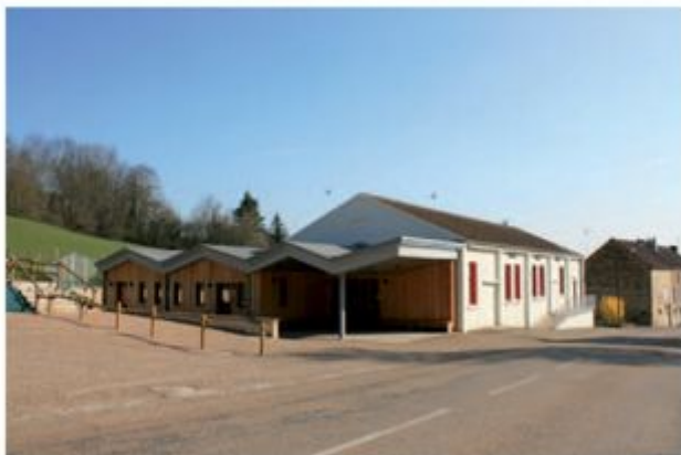
Extension de la salle des fêtes d'Iguerande, Mireille Rouleau architecte Ce projet rénove le bâtiment existant et s'inscrit dans son gabarit. L'extension par son volume ne dépassant pas la ligne de sablière met en avant le bâtiment d'origine
