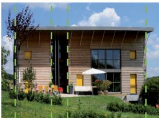
Façade contemporaine réinterprétant des ouvertures typiques des bâtiments du Charolais Brionnais. Exemple de la baie vitrée rappelant les ouvertures de granges mais jouant un rôle énergétique de jardin d'hiver. Maison individuelle privée (Mancey, 71), Pierre et Karine Rattiez arch.
