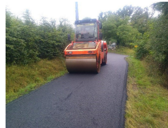
Saint-Agnan, lieu-dit « Les Juliens », 1 974 m 2 d'enrobé à chaud Coût : 18 654 € HT.
