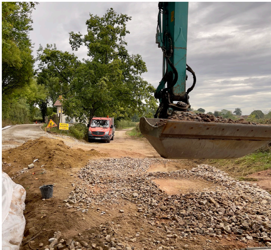
Travaux de création d'un cheminement doux à Charolles.
