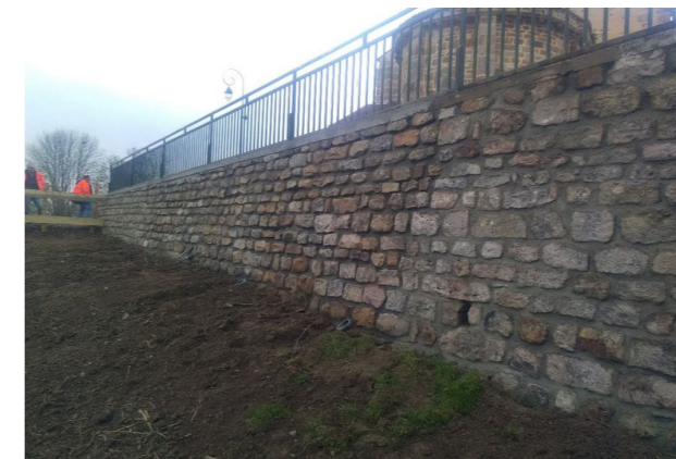
Mur de soutènement au bourg de Baron : travaux de reconstruction ont eu lieu en février. Coût : 22 036 € HT.
