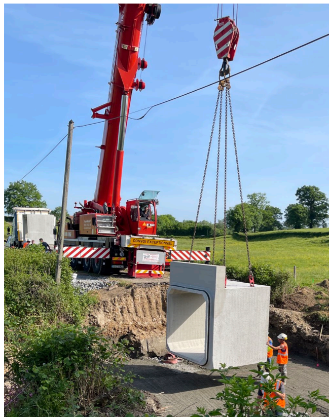
Pose des ponts-cadres
