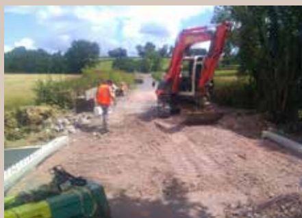
Travaux (59 871,80 € HT subvention 30%)
