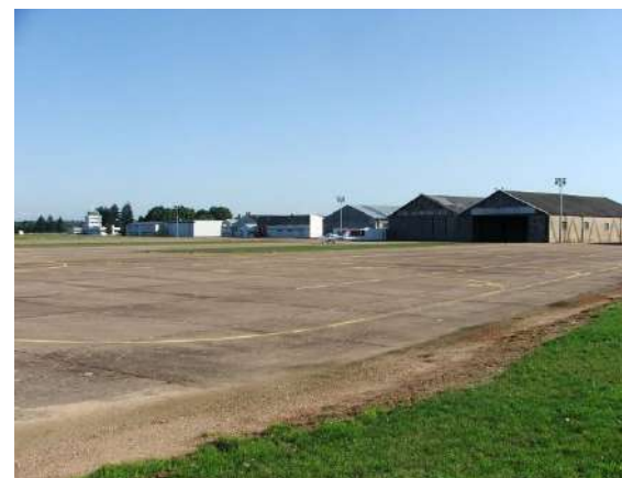
Infrastructure de l'aéroport de Saint-Yan
