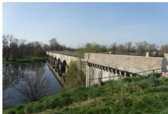
Pont-canal à Digoin
