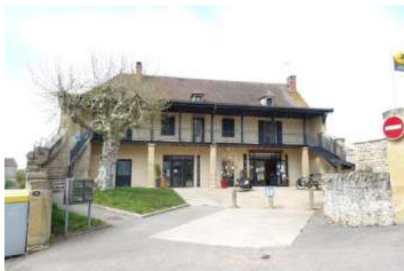
Boulangerie à Saint-Julien-de-Civry
