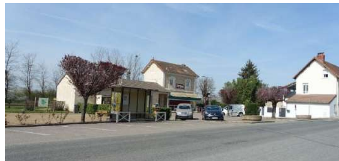
Ancienne gare de Saint-Agnan. L'accès aux quais se fait en passant à droite
