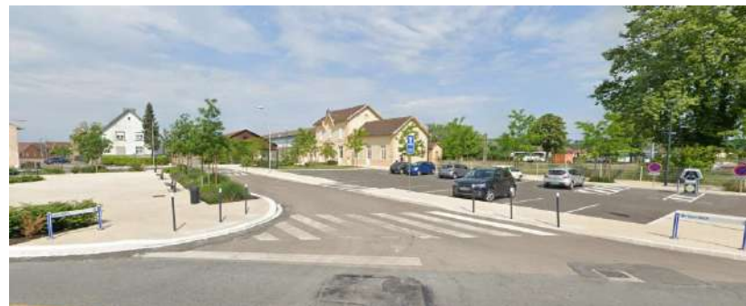
Gare de Digoin et aménagements des abords
