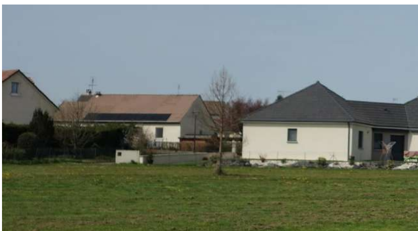
Photovoltaïque en toiture – Paray-le-Monial
