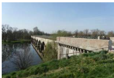
Le Pont Canal // Digoïn
