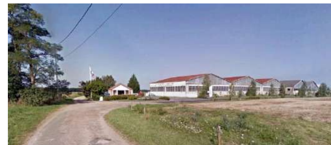
Bâtiments de l'aéroport de Saint-Yan
