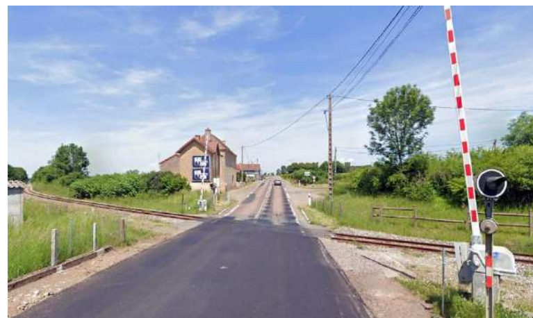
RD 985 – Changy – Entrée majeure au niveau de la voie ferrée
