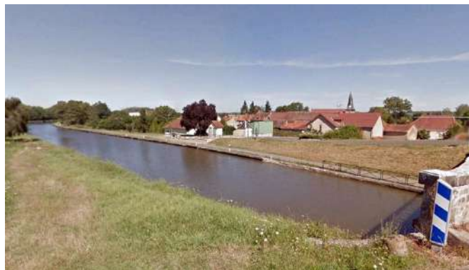
Halte nautique à requalifier à Coulanges
