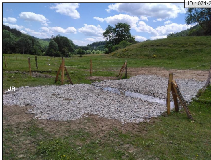
Un des passages à gué juste après réalisation à Cussy en Morvan
