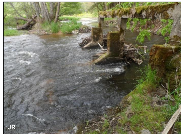
A gauche : la maison en arrière-plan qui est menacée. On observe les vestiges qui se sont végétalisés et qui bloquent les gros bois ce qui réduit la section d'écoulement. A droite, les anciens vannages qui auraient dû être démontés pour limiter la fixation d'embâcles
