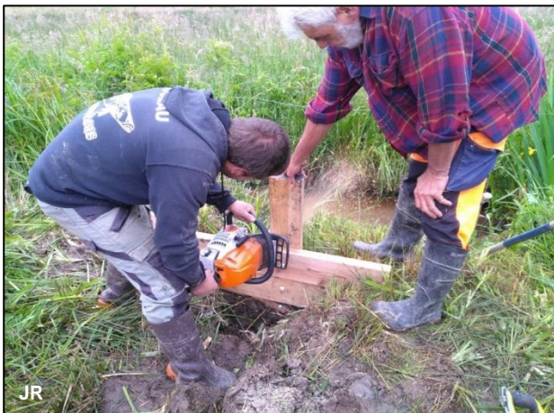
A gauche : l'aménagement du bouchon d'obturation en fin de fossé. A droite : le résultat en Janvier 2023
