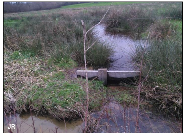
A gauche : l'aménagement du bouchon d'obturation en fin de fossé. A droite : le résultat en Janvier 2023
