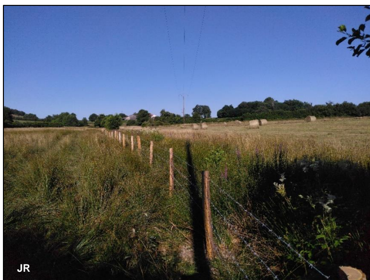
A gauche, après travaux ; A droite : avant travaux
