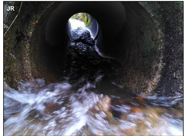
Le détail d'une des deux buses vues depuis l'amont
