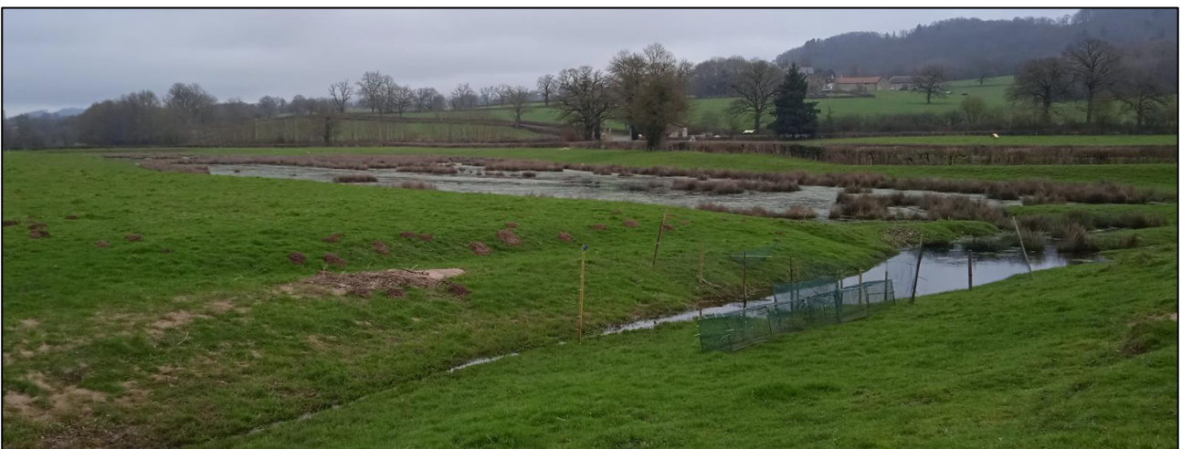
Annexe hydraulique des Chaintres à Etang-sur-Arroux.
